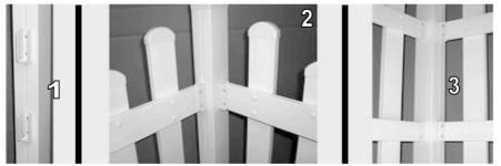
2. Montieren Sie die Montageschuhe an den Pfosten (1). Vorbohren 3,5mm und verschrauben mit 4 x 35mm. Anschließend hängen Sie das Zaunfeld ein und verschrauben es. Vorbohren 3,5 mm und verschrauben mit 4 x 22mm (2+3)
