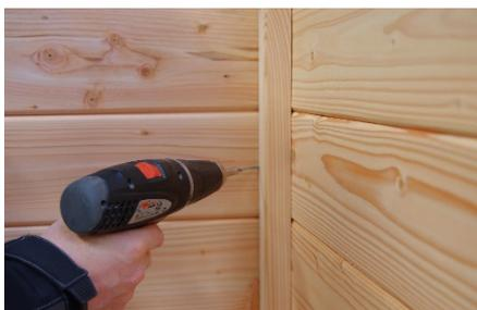
Fixieren Sie jedes Brett mittig mit einer Schraube von 3,2x40mm. Diese werden seitlich schräg in die Nut geschraubt. Beim obersten Brett muss die Feder in einem Streifen von 2cm abgeschnitten werden. Darauf kommt die Abdeckleiste. Diese ist mit 178,5cm etwas länger. Auf passende Länge zuschneiden und von oben festschrauben (vorbohren).
