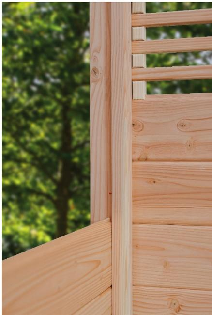
Die Steckzaun-Bretter schieben sie in die Nuten der Pfosten. Hierbei ist die Feder des Brettes nach oben gerichtet (Wasserablauf). Das unterste Brett sollte ca. 3cm von der Pfostenunterkante beginnen.
