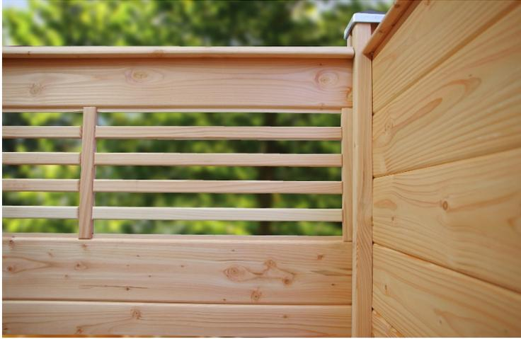
Der Gittereinsatz (optional) wird ebenfalls in die Nut geschoben. Drehen Sie das oberste Brett um, sodass die Feder nach unten zeigt und in die Nuten der Gitterleisten fasst. Hier wird beim obersten Brett nicht die Feder, sondern die Nut mit einem ca. 2cm breiten Streifen längs abgeschnitten.
