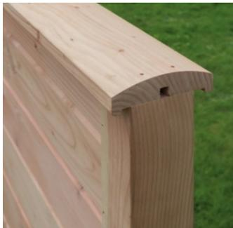
Hierzu muss die oberste Aarberg Bohle ca. 10mm über die Pfostenoberkante überstehen. Die Abdeckbohle hat eine Länge von 225cm und muss angepasst werden. Zum Festschrauben eignen sich Edelstahlschrauben 4,5x60mm (Vorbohren!).
