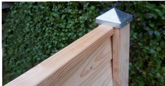
Fixieren Sie jedes Brett mittig mit einer Schraube von 3,5x55mm. Diese werden seitlich schräg in die Nut geschraubt. Auf das oberste Brett kommt die Abdeckleiste 3x5cm. Diese ist mit 200cm etwas länger. Einfach maßgerecht anpassen und von oben festschrauben (vorbohren).
