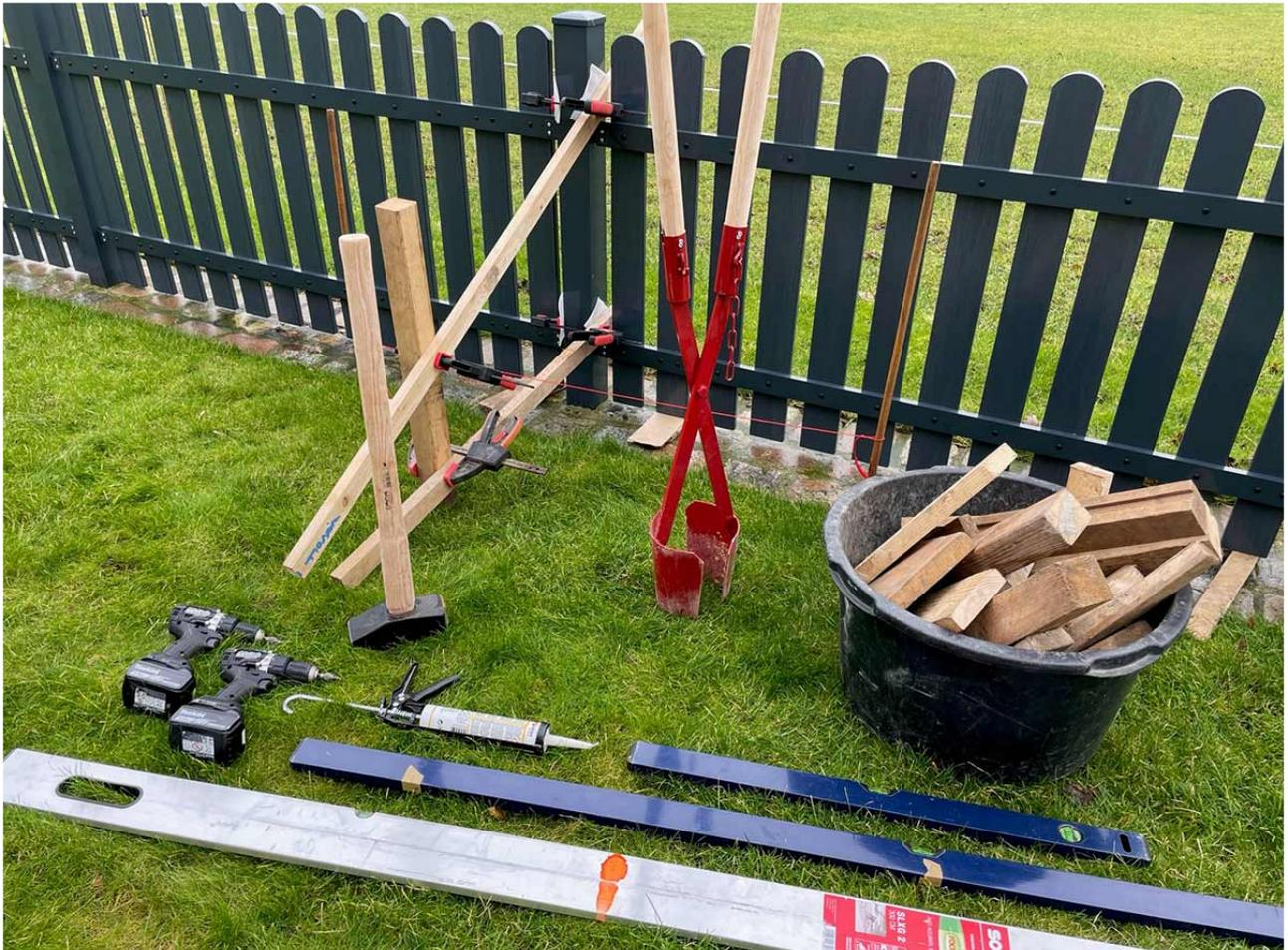
2.2.1 **Zunächst das erste Zaunfeld** mit beiden Pfosten auf Hilfsböcken vormontieren und in die vorbereiteten Löcher stellen. Korrekte Starthöhe (also Unterkante Zaunfeld) vorher mit einigen 30-40cm langen Unterlegbrettern und langer Wasserwaage „aushöhen“. Dabei werden zwei Holz-Stapel am Feldanfang und am Feldende quer zum Zaun auf die gewünschte Höhe aufgebaut.
