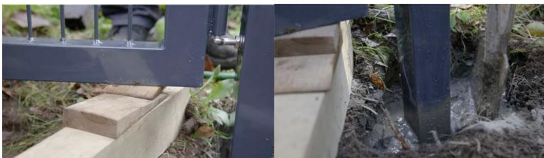
Nun richten Sie das Doppelstabmattentor mit der Wasserwaage so aus, dass es lotrecht steht. Fixieren Sie das Tor mit den Holzlatten.
