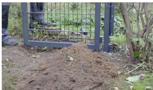
Das Tor wird nun mit Hilfe des Unterlegmaterials auf die richtige Höhe gebracht. Mit der Wasserwaage sollten Sie kontrollieren, ob das Tor in der Waage ist und gegebenenfalls mit den Holzkeilen nachjustieren.
