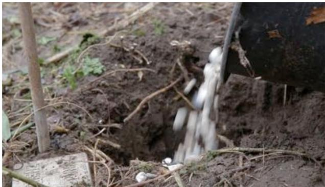
Als erstes füllen Sie eine ca. 10cm Starke Kiesschicht in jedes Loch. Diese wirkt kapillARBrechend und schützt das Pfostenfundament vor Frostschäden.
