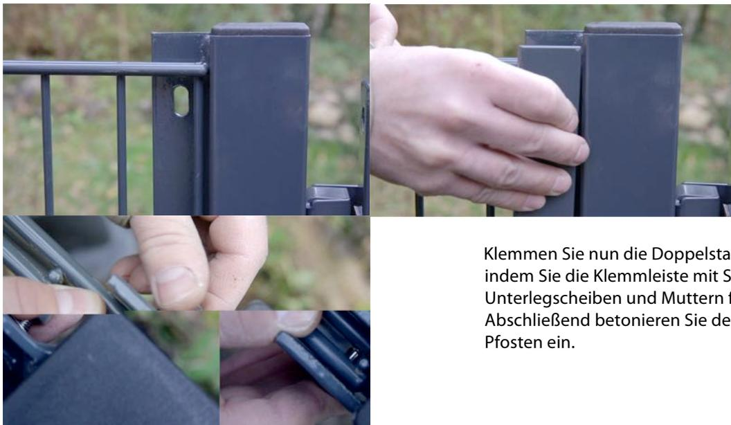
Klemmen Sie nun die Doppelstabmatte ein, indem Sie die Klemmleiste mit Schrauben, Unterlegscheiben und Muttern festziehen. Abschließend betonieren Sie den zweiten Pfosten ein.
