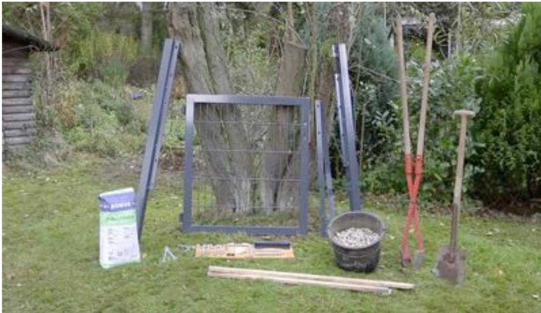
Die einflügeligen Doppelstabmatten Tore haben eine Standardbreite von 1,0 m und sind in Höhen von 0,6 m bis 2,0 m erhältlich. Die Ausführungen bis 1,4 m Höhe werden meist mit 6 x 6 cm Pfosten geliefert, die Ausführungen über 1,4 m Höhe meist mit 8 x 8 cm Pfosten. Zu den Beschlägen gehören Türdrücker, Scharniere und Anschlagsblech, sowie sämtliche für die Montage notwendige Schrauben.
