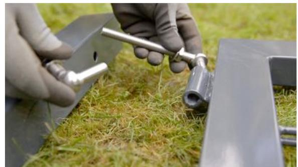
Nun nehmen Sie die Bänder und stecken diese zum einen in die an dem Tor vorgesehenen Taschen und zum anderen durch die am Pfosten vorgebohrten Löcher. Falls die Löcher durch die nachträglich aufgebrachte Pulverbeschichtung etwas zu eng sind, feilen Sie diese mit einer Rundfeile vorsichtig aus. Nun schrauben Sie die Bänder mit Hilfe der mitgelieferten Unterlegscheiben und Muttern fest.
