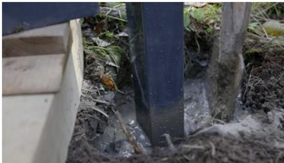
Als nächstes betonieren Sie den Pfosten ein, indem Sie entweder Betonestrich in das Pfostenloch schütten und mit Wasser vermischen oder indem Sie Betonestrich vorher in einem Eimer anmischen und anschließend in das Loch schütten.
