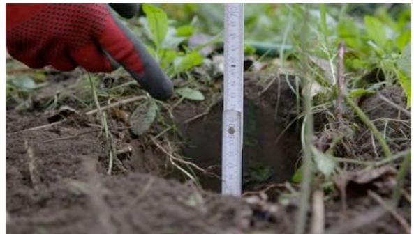
Die Löcher sollten eine Tiefe von mindestens 60 cm und eine Seitenlänge von ca. 30cm haben. So gehen Sie sicher, dass das Fundament in einer frostfreien Tiefe aufsitzt. Nun werden die darauffolgenden Löcher ausgehoben. Der Abstand zwischen den Löchern sollte von Lochmitte zu Lochmitte ca. 1,06m betragen.
