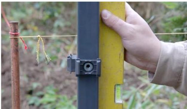
Abschließend richten Sie den Pfosten lotrecht mit Hilfe der Wasserwaage aus. Wir empfehlen für den ersten Pfosten schnellabbindenden Beton wie beispielsweise „Ruck Zuck Beton“ zu nutzen, dann können Sie bereits nach ca. 15 Minuten weiterarbeiten und die erste Matte montieren.
