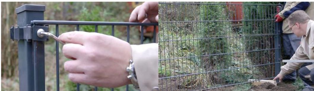
Jetzt unterfüllen Sie die Doppelstabmatte mit Holzkeilen und Erde bis diese in der Waage ist. Anschließend können Sie den zweiten Pfosten an der Matte montieren. Wenn Sie die einfachen „O-Pfosten“ verwenden, reicht es die Matte nur mit der obersten Pfostenklammer zu befestigen. Dies erleichtert das senkrechte Ausrichten, das nun folgt.
