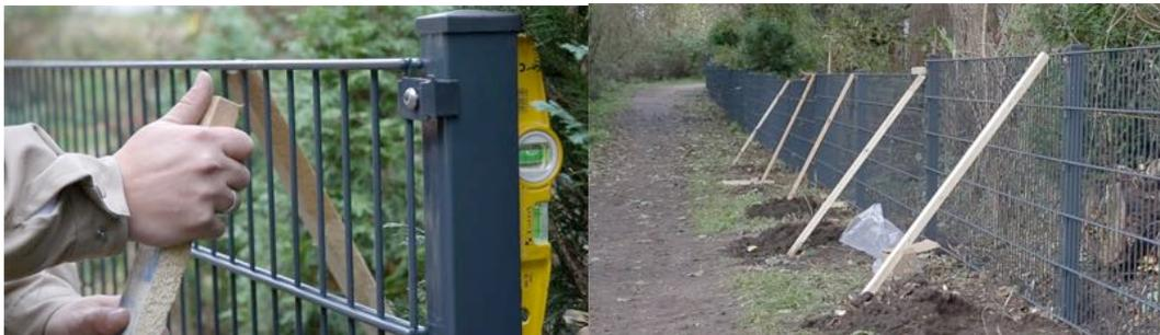
Die fertig ausgerichtete Matte wird mit Holzplatten abgestützt und fixiert. Abschließend betonieren Sie den zweiten Pfosten ein. Nachdem der Beton abgebunden hat, können Sie die übrigen Pfostenklammern befestigen. Um die Zaunanlage fortzuführen, können Sie nun in gleicher Weise mit der nächsten Doppelstabmatte und dem nächsten Pfosten verfahren, bis Sie an das Ende des geplanten Zauns gelangen.
