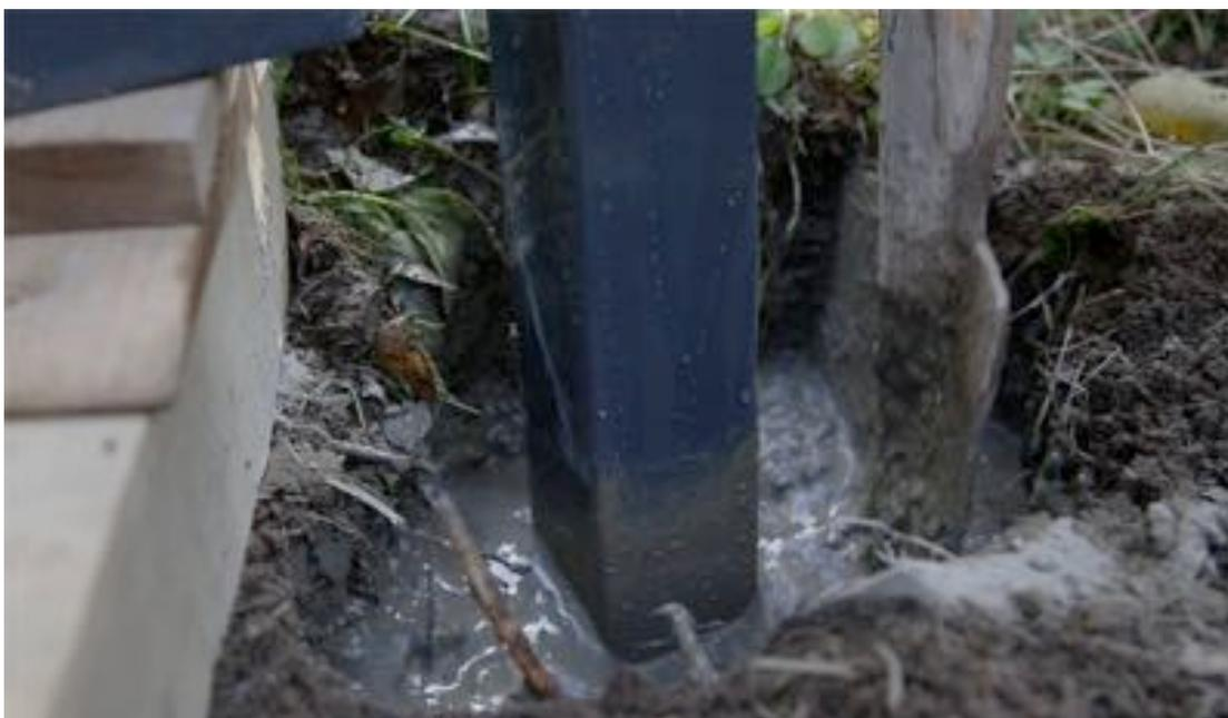
Alternativ können Sie den Betonstrich im Eimer anmischen und dann in das Loch schütten. Es sollte so viel Beton eingebracht werden, dass später noch eine ca. 10 cm starke Erdschicht auf das Fundament gelegt werden kann. Nun setzen Sie den ersten Pfosten in den Beton. Achten Sie darauf, dass der Betonstrich in und um den Pfosten liegt, ggf. mit dem Spatenstiel oder einem Eisenstab etwas nachhelfen.
