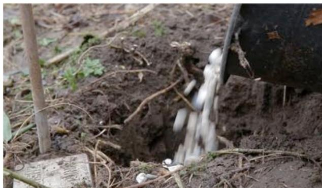
Als nächstes können Sie den trockenen Betonstrich mit etwas Wasser in das Loch schütten und anschließend mit einem Spaten im Loch anmischen.
