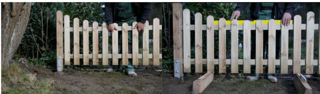
Das ausgerichtete Zaunelement nun an den Pfosten mit den Zaunbeschlägen schrauben. Die Befestigung des zweiten Pfosten erfolgt ähnlich der des Ersten. Zuerst wird der Pfosten mit den H-Pfostenträgern verbunden und die Zaunbeschläge vormontiert. Dann wird der zweite Pfosten in das ausgehobene Loch gesteckt und zuerst in der Höhe ausgerichtet. Als nächstes den zweiten Pfosten mit Hilfe der Wasserwaage lotrecht ausrichten und mit dem Ruck Zuck Beton einbetonieren.
