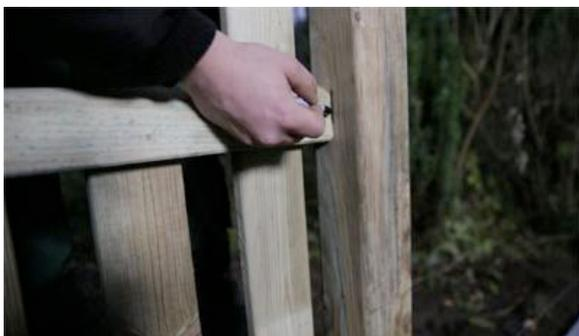
Nach dem Einbetonieren des ersten Pfostens werden die Zaunbeschläge am Pfosten befestigt. Hierfür setzen Sie das Zaunelement an den Pfosten und markieren den Sitz der Zaunbeschläge. Dabei sollten Sie darauf achten, dass die Winkel so montiert werden, dass das Zaunelement mittig zwischen den Pfosten sitzt.
