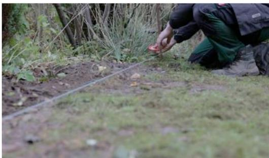
Abhängig von dem geplanten Zaunverlauf, ziehen Sie eine Richtschnur gemäß dem Zaunverlauf. Hierfür werden zuerst die Pflocke, an denen die Richtschnur befestigt wird, in den Boden geschlagen. Die Pflocke sollten direkt auf der Grundstücksgrenze eingeschlagen werden.
