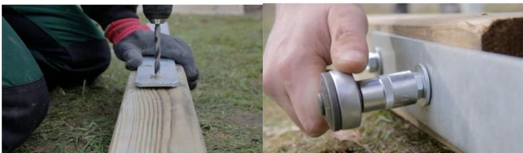
Nun die Durchgangsschrauben mit Hilfe des Hammers durch die Bohrlöcher treiben. Nach dem Aufstecken der Unterlegscheiben die Muttern der Durchgangsschrauben mit dem Schraubenschlüssel festziehen. Jetzt eine ca. 10cm starke Kiesschicht in die ausgehobenen Löcher füllen, diese wirkt kapillarbrechend und macht das Pfostenfundament frostsicher. Die fertig montierten Pfosten in das erste Loch stecken und die Höhe des Pfostens anhand der Richtschnur bestimmen.
