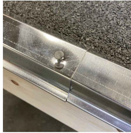
Links eine Ecke, rechts ein Stoß zweier Giebelleisten
