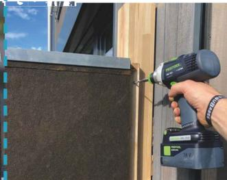
▶ 3 Befestigung am zweiten Pfosten mit Element
