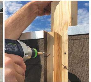
3 Befestigung am zweiten Pfosten mit Element
