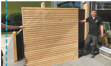
5 gewünschte Sichtblenden beidseitig aufschrauben
