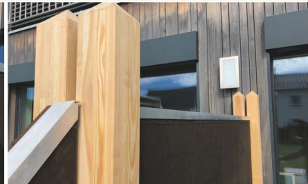
5 gewünschte Sichtblenden beidseitig aufschrauben
