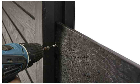
Fastgørelse af brædder, skrue i hver side.
