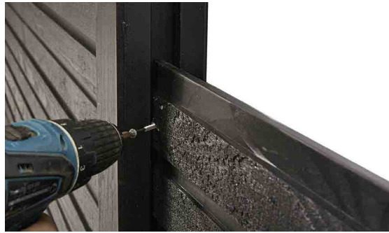
Fastgørelse af brædder, skrue i hver side.
