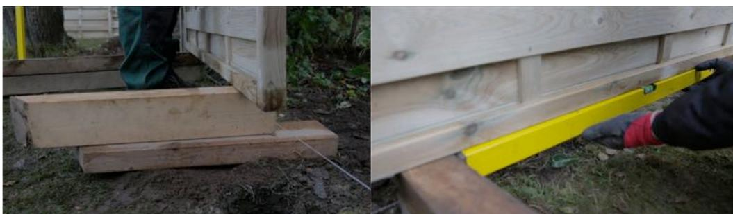
Die Feinausrichtung der Zaunelemente kann mit Hilfe eines Zollstocks erfolgen oder indem man etwas Erde unter dem Unterlegmaterial zufügt oder wegnimmt.
