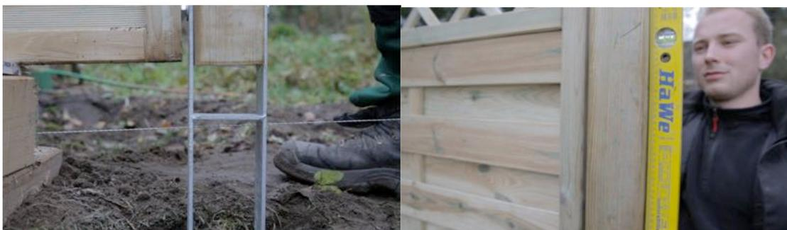
Als nächstes den zweiten Pfosten mit Hilfe der Wasserwaage lotrecht ausrichten und mit dem vorher angemischtem Ruck Zuck Beton einbetonieren. Abschließend schrauben Sie das Zaunelement an den Pfosten.
