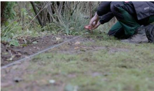
Abhängig von dem geplanten Zaunverlauf, ziehen Sie eine Richtschnur gemäß dem Zaunverlauf. Hierfür werden zuerst die Pföcke, an denen die Richtschnur befestigt wird, in den Boden geschlagen. Die Pföcke sollten direkt auf der Grundstücksgrenze eingeschlagen
