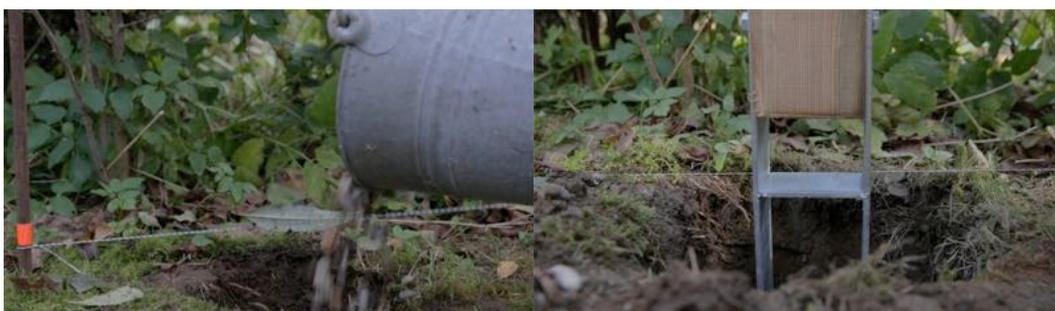
Jetzt richten Sie den Pfosten mit Hilfe der Wasserwaage lotrecht aus. Abschließend füllen Sie den Beton in das Loch und stampfen diesen fest und richten den Pfosten erneut aus.
