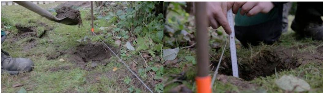
Nun werden die darauffolgenden Löcher ausgehoben. Der Abstand zwischen den Löchern ergibt sich aus der Breite der Zaunelemente plus der Stärke der Pfosten.
