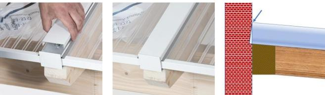
23. Das Wandanschlussprofil wird alle 50 cm vorgebohrt und mit geeignetem Befestigungsmaterial an der Hauswand befestigt. Die Gummilitze muss im Bereich der Profile eingeschnitten werden, damit sie Ihre Dichtwirkung erzielen kann. Im Anschluss wird die obere Kante mit Silikon versiegelt. Abschließend die Wandanschluss-Seitenteile anschrauben und mit Silikon abdichten.
