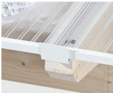
21. Die Deckel des Kompletprofil werden alle 25 cm in der mittleren Kennrinne vorgebohrt und auf die Unterprofile lose aufgelegt und mit den selbstschneidenden Schrauben 5,5 x 85 mm mit dem Unterprofil und der Unterkonstruktion verschraubt. Schrauben nur „handfest“ anziehen, bis ein leichtes Quetschen der Abdichtscheibe durch den Schraubkopf erfolgt, damit die Platten sich nachträglich noch ausdehnen können!
