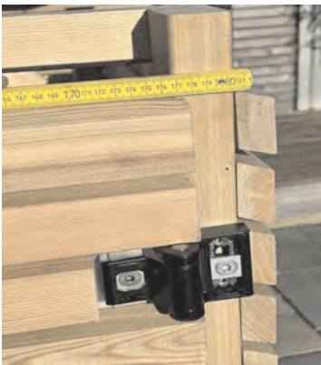
Die Türen an der Oberkante Rhombusleiste ausrichten.
