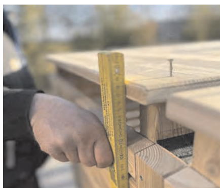
3-Schichtplatte bündig zur Rückwand ca. 7 mm re/li ausgemittelt
