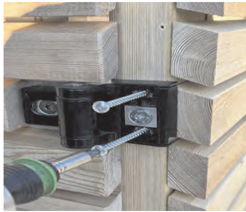
Die Bänder zusätzlich mit den Spax 5x70 mm anschrauben. Abdeckungen anbringen
