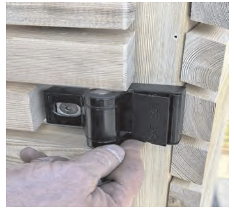
Die Bänder zusätzlich mit den Spax 5x70 mm anschrauben. Abdeckungen anbringen
