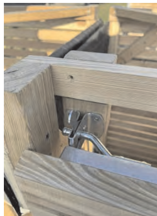
Schließer in Schnapper einrasten lassen, die Position mit Stift markieren und an den Markierungen festschrauben (4,5x35 mm)
