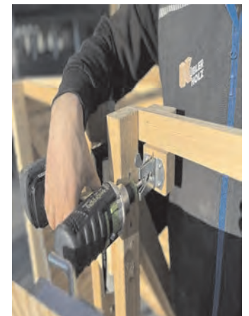
Schließer in Schnapper einrasten lassen, die Position mit Stift markieren und an den Markierungen festschrauben (4,5x35 mm)
