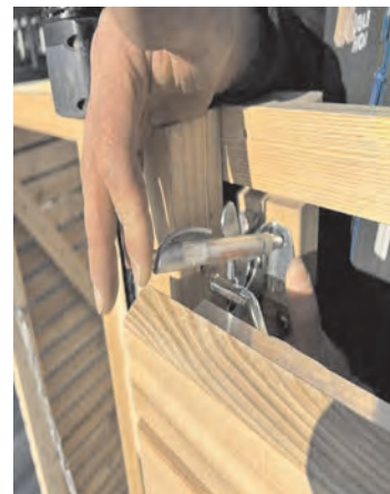
Schließer in Schnapper einrasten lassen, die Position mit Stift markieren und an den Markierungen festschrauben (4,5x35 mm)
