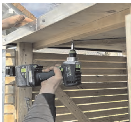
Das EPDM-Dach von unten verschrauben (4,5x60 mm).
