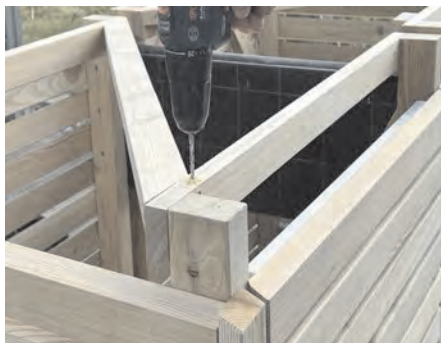
Die Dachstreben durchbohren
