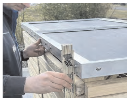
Das Dach bündig zur Aussenkante Rhombusleiste ausrichten
