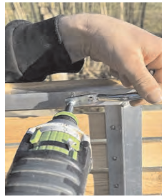
Türverschluss montieren(Panhead 5x50 mm).
