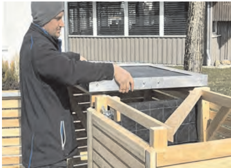
Das vormontierte EPDM-Dach auflegen
