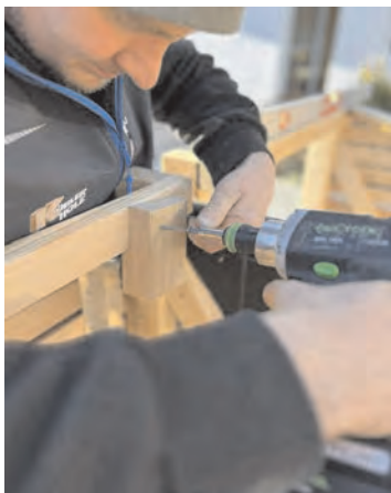
Halter für Türverschluss anschrauben (4,5x50 mm)
