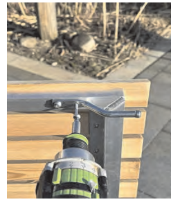
Türverschluss montieren(Panhead 5x50 mm).
