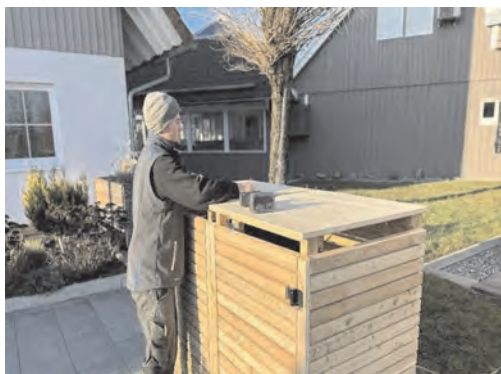
3-Schichtplatte auf dem Modul platzieren
